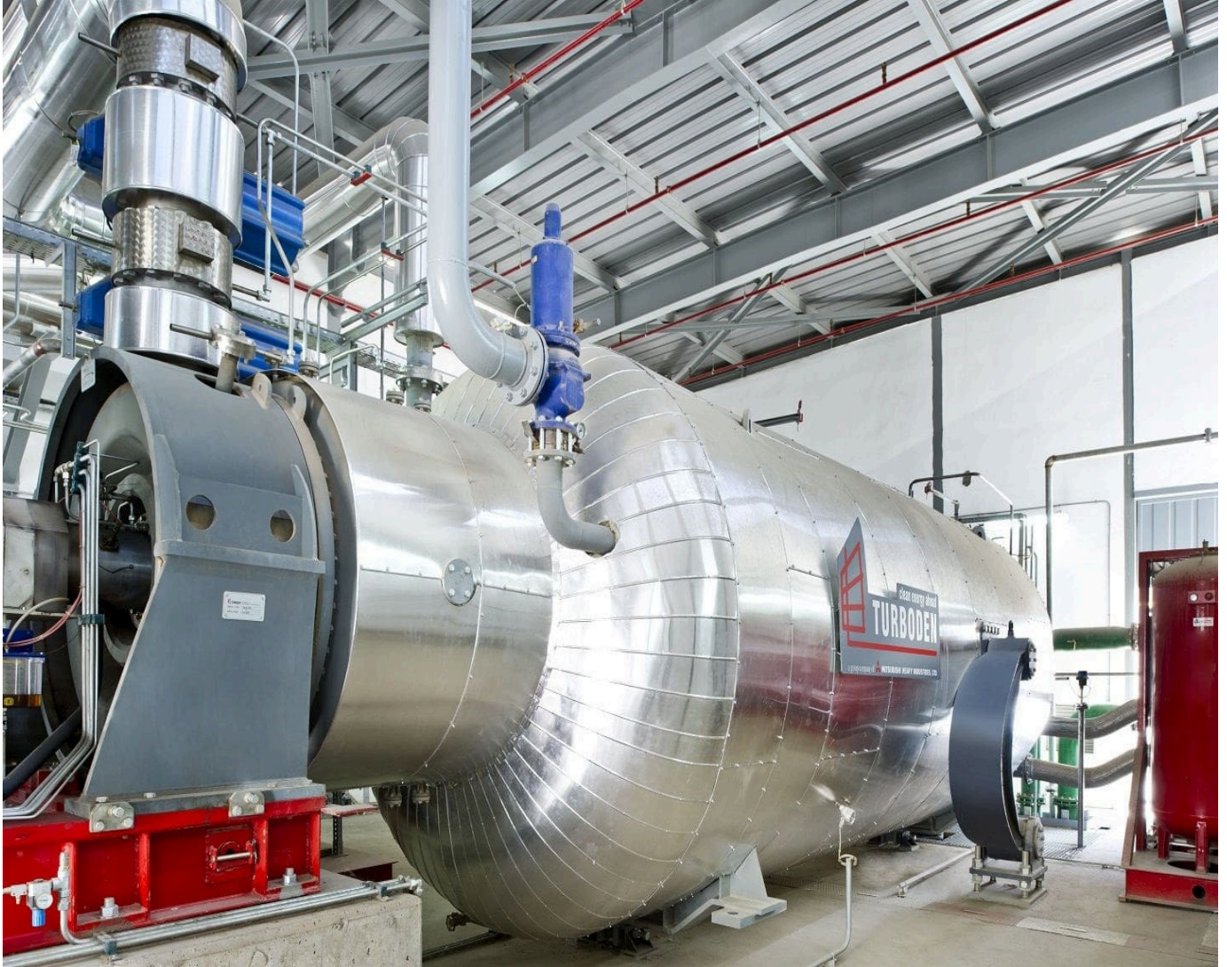
Şekil 5. ORC Türbin & Jeneratör
